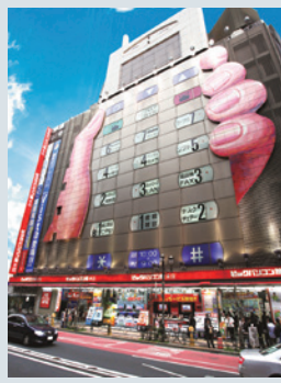
携帯電話の流行を予見するパソコン館本店の外観
