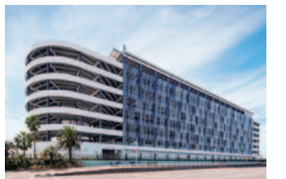
新たに稼働する船橋商品センター
